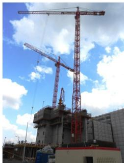
Beide WÖLFFE wurden zu Beginn freistehend montiert und Stück für Stück geklettert. Der WOLFF-Vorteil: Die beiden Krane mussten nur zwei- bzw. dreimal am Gebäude abgespannt werden, was Kosten einsparte.
